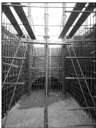
图 4 拉筋加固图
