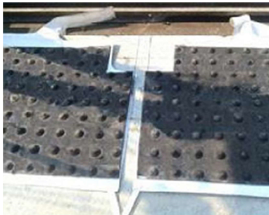
图 2 橡胶减振系统铺设
