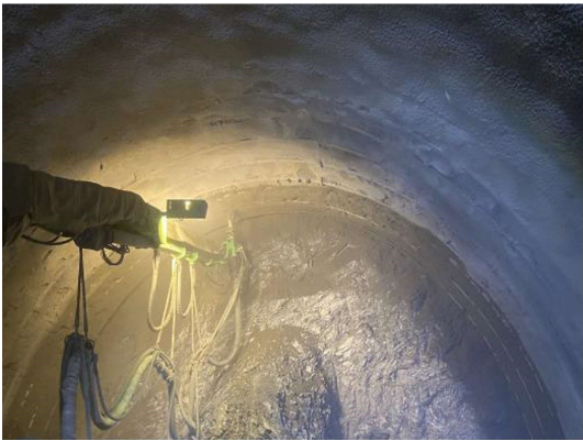
图 2 隧道喷射混凝土初期支护作业
