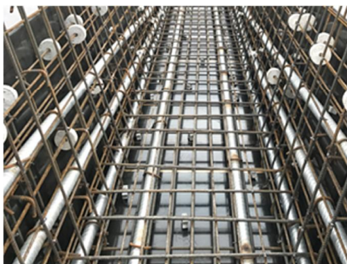
图6 圆形中空垫块使用
