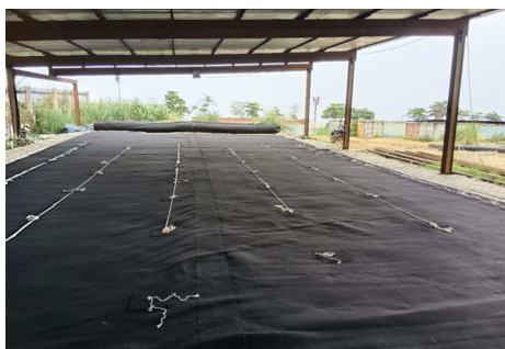
图 3 土工布热熔连接
