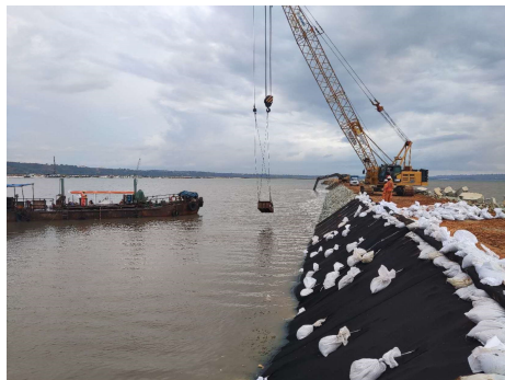
图 4 土工布铺设压载
