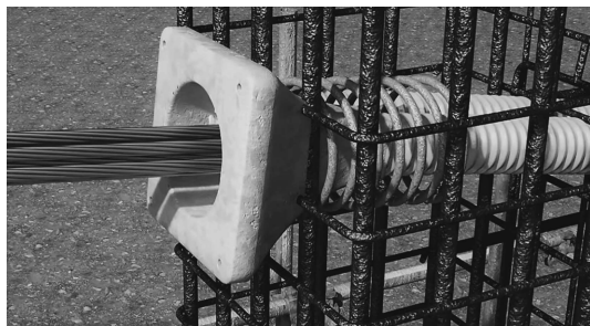
图 1 锚垫板、螺旋筋及波纹管三同心安装示意图
