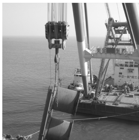
图4 起重船拆除护舷
