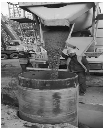
图6 混凝土入桩
