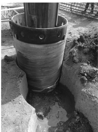
图7 切割超缓凝混凝土桩
